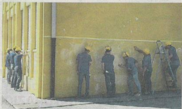
IL RECUPERO I giovani della scuola edile al lavoro per ripristinare i muri esterni dell'istituto deturpati dai vandali
